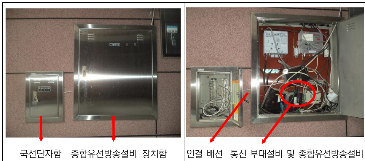
[그림 2-1] 국선단자함과 장치함을 각각 설치한 사례
