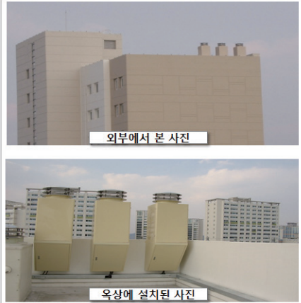
<환기시설에 설치된 안테나 설비 설치 예>
