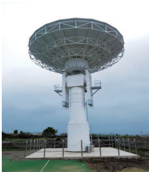
10m안테나 시스템(고도: 0 \sim 90 도, 방위: \pm 170 도)
