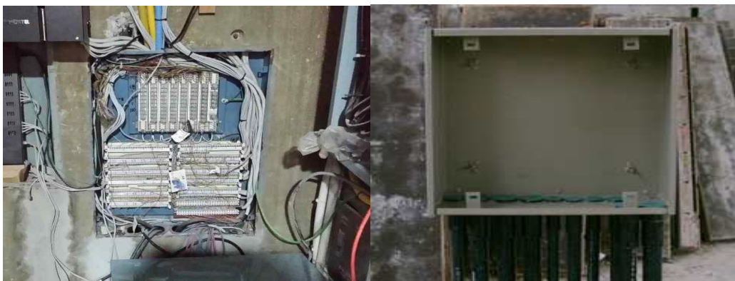
[그림 2-3] 절연보조장치가 설치되지 않은 국선단자함 내부 사진
