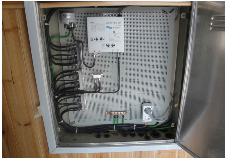
[그림 2-2] 방송 장치함 내부 절연보조장치 설치 사진
