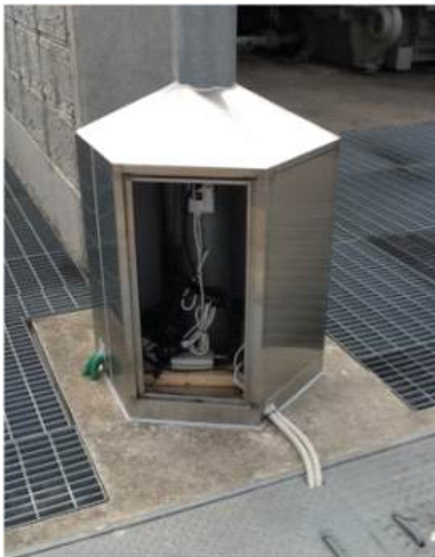
[그림 3-11] 변압기 중성점 센서 설치
