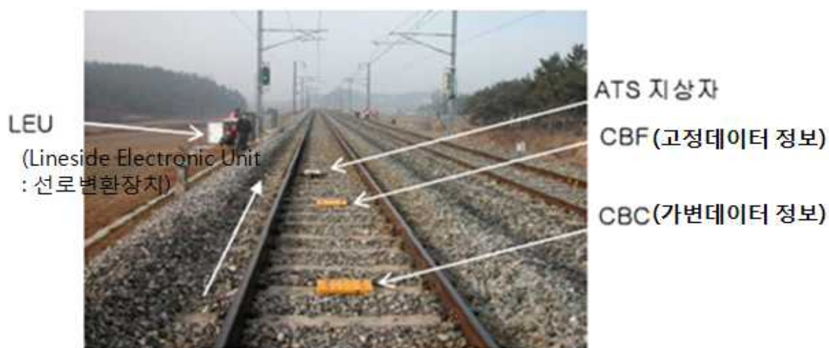
[그림 4-4] ATP 지상설비 설치 현장
